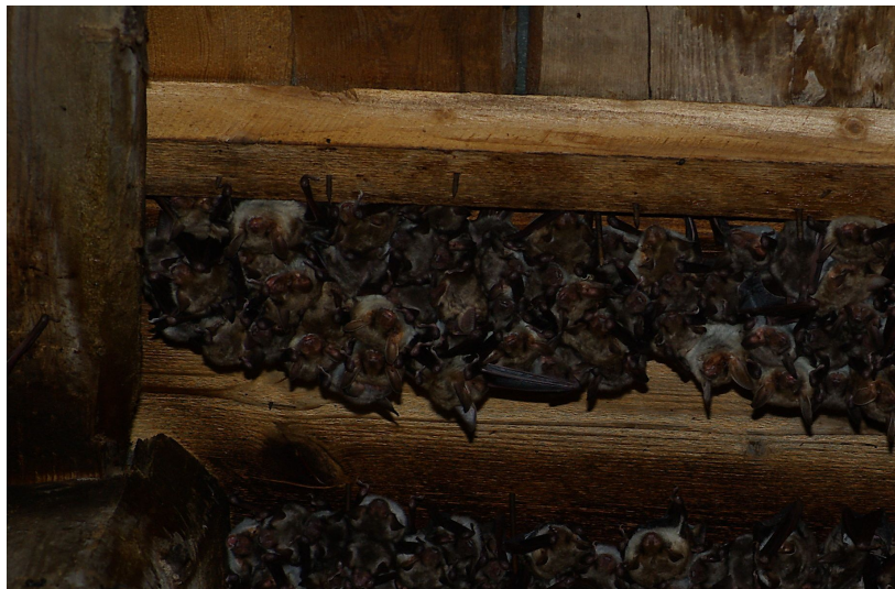
Kolonia nocka dużego na strychu kościoła. Fot. T. Gottfried
