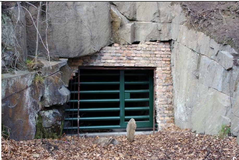
Fot. 3. Nowa krata w dolnym wejściu (nr 2) do Sztolni Baworowo I jest wykonana w sposób bezpieczny dla nietoperzy, 14.01.2012, fot. Tomasz Gottfried.
