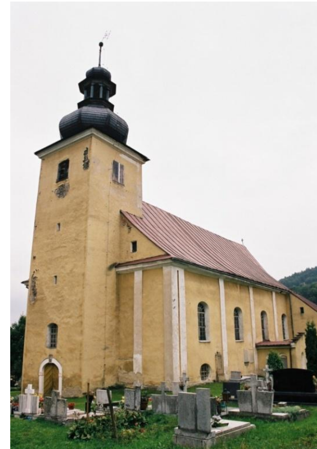
Fot. 2. Okna w wieży i na strychu kościoła w Konradowie umożliwiają nietoperzom swobodny wlot do budynku, 17.10.2011, fot. Łukasz Płoskoń.
