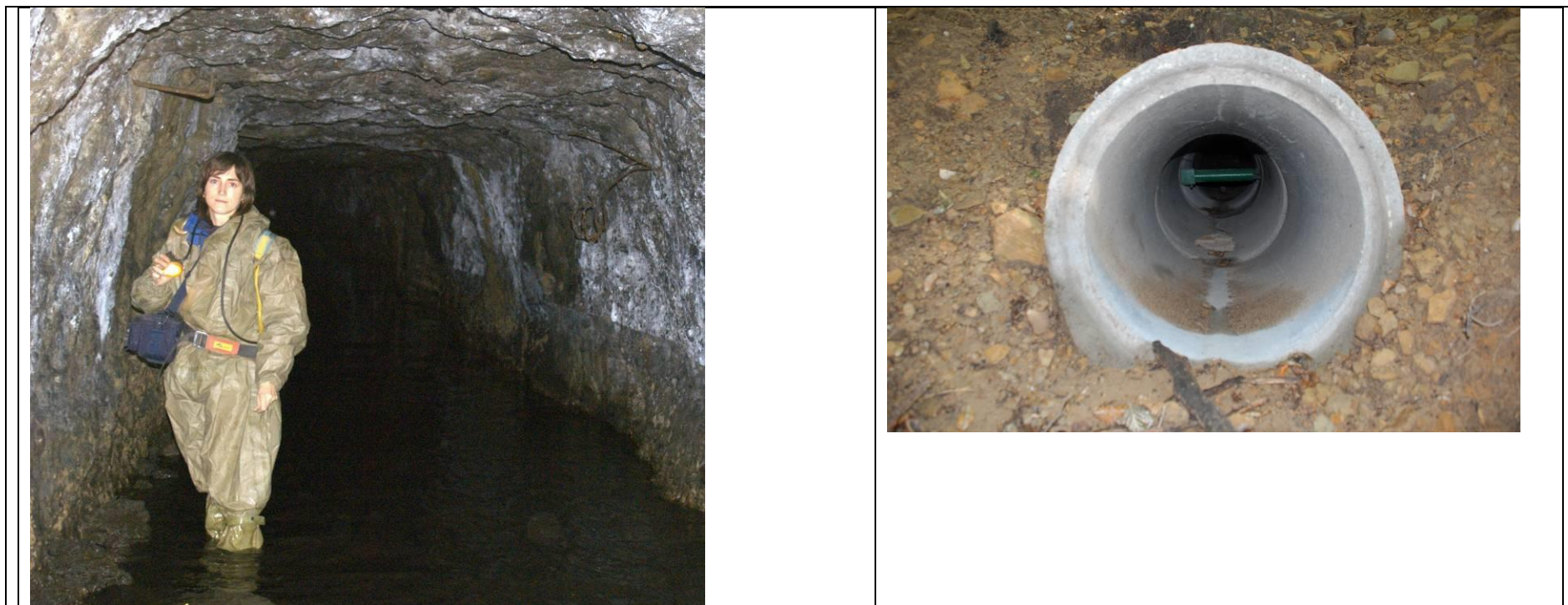
Fot. 2. Sztolnia Gustaw (po lewej) i zabezpieczenie jej otworu wejściowego (po prawej). Fot. P. Woźniak i J. Furmankiewicz.
